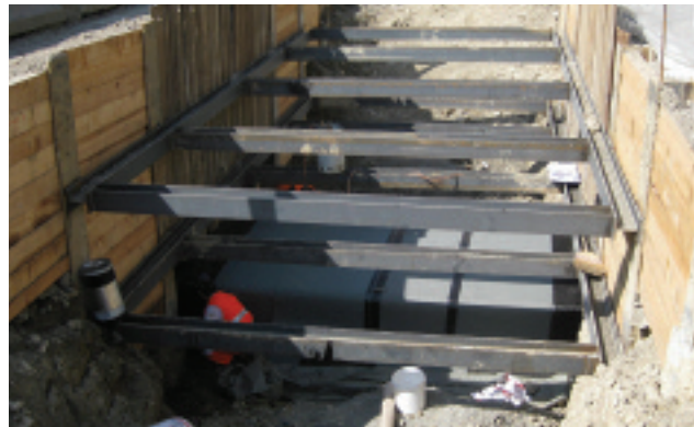
Baugrube für unterirdische Installationen
