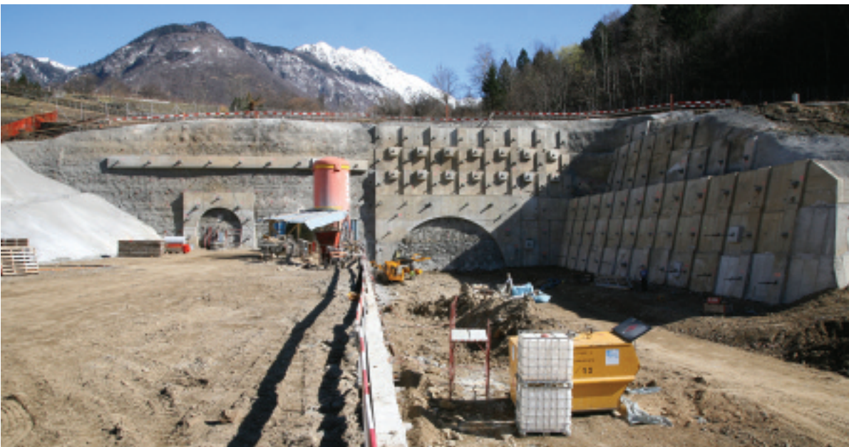
Baustelle auf der A13, Umfahrungstunnel Roveredo TI
